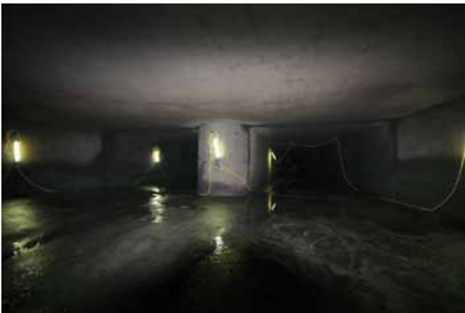
▲ Durch Flutkanäle unter dem Schleusenbecken erfolgt der Zulauf während des Schleusungsvorganges bei der Bergschleusung.
