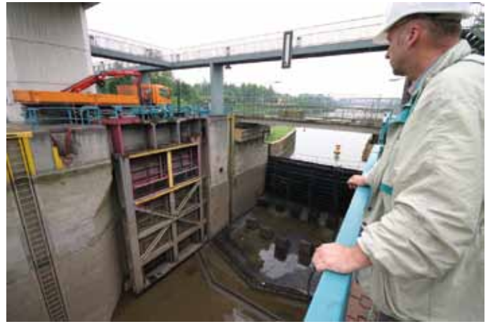
▲ Inspektion des Stemmtores am Unterwasser durch den Leiter des WSA Außenbezirks Duisburg-Meiderich.
