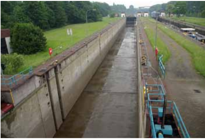
▲ Die für Instandsetzungsarbeiten trocken gelegte Nordkammer der Oberhausen-Liricher Schleuse.
